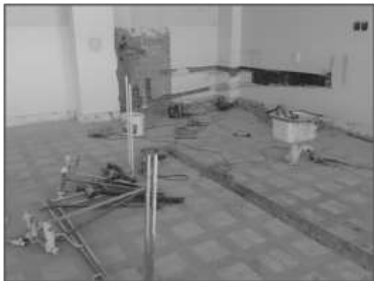
Foto: Rekonstrukce školní kuchyně
